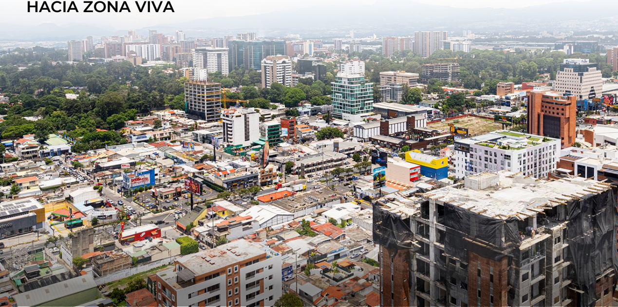
VISTA OESTE HACIA ZONA VIVA
