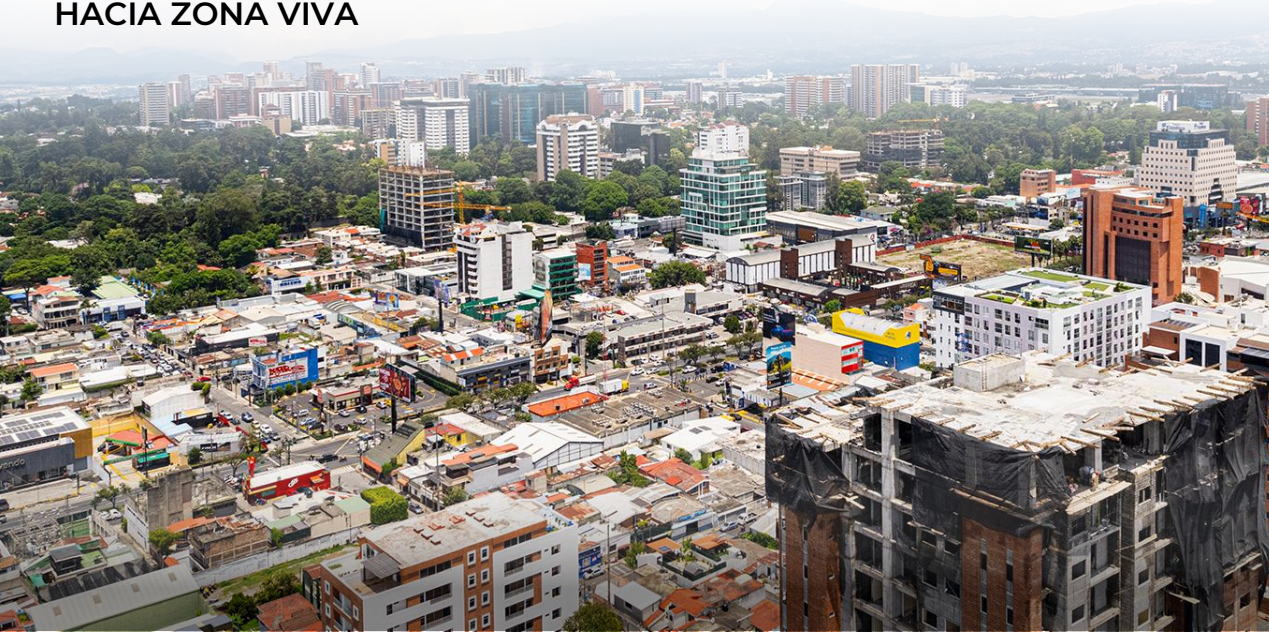
VISTA OESTE HACIA ZONA VIVA
